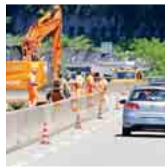
I ragazzi percorrono a piedi il tratto interessato ai lavori
