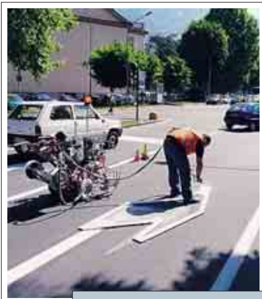
LAVORI Si sistema la segnaletica
