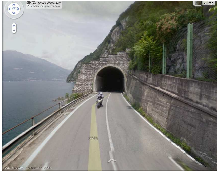
Galleria Morcate (Varenna – Bellano), ingresso Sud. Presidio Polizia di Stato - Carabinieri
