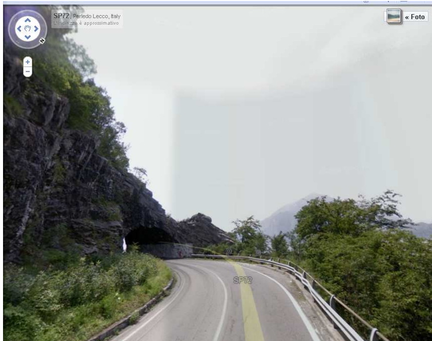
Galleria Morcate (Varenna – Bellano), ingresso Nord. Presidio Polizia di Stato - Carabinieri
