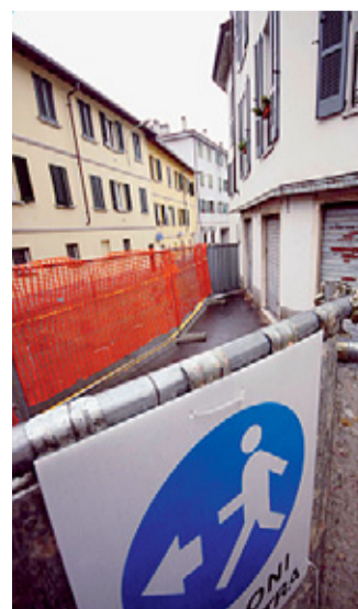
L'area di cantiere all'ex Giglio
