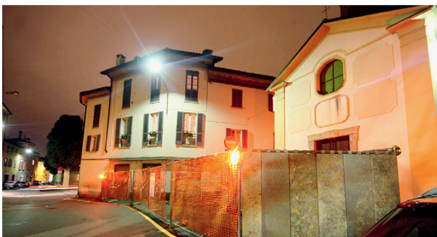
Il cantiere dell'ex Giglio: sui muri erano stati scoperti affreschi, ora una scoperta di tutt'altro genere: resti di uno scheletro
